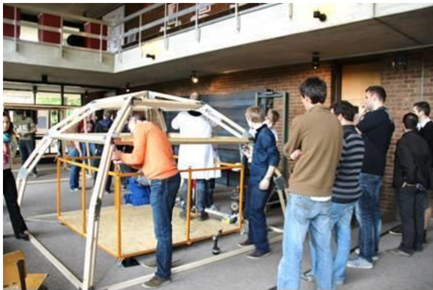
Figure 2 : Accrochage de la "cage" métallique sur l'une des structures
